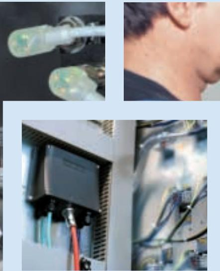
**Stromversorgung sowie Profibus- und Sicherheitssignale laufen über die kompakte Anschlussbox des mobilen Panels, hier im zentralen Schaltschrank der Maschine installiert**
