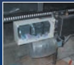
**Angetrieben werden die Vorhänge mit 18 Frequenzumrichtern des Typs Sinamics G110**
